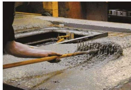
Vagnar med betong tömmer sin last rakt ner i de vaxbestrukna formarna där den sedan fördelas jämt. Armering och isolering fylls snabbt upp och elementet rullar sakta vidare på sitt band.
